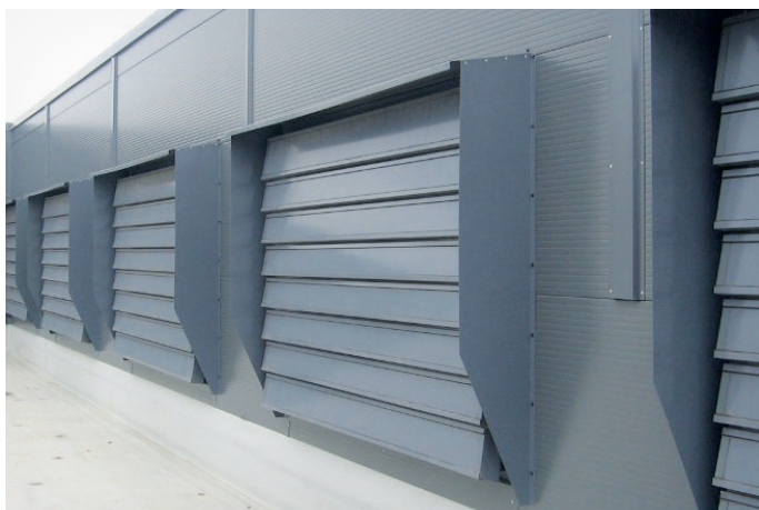
Foto. III–IV In der Fassade montierte mcr LAM Lüfter mit Regenabweiser
