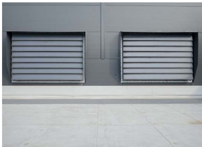
Zdjęcie. III–IV Kłapy napowietrzające mcr LAM-N wyposażone w osłony przeciwdeszczowe
