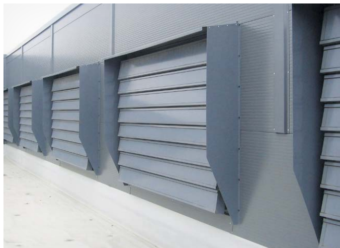
Zdjęcie. III–IV Kłapy napowietrzające mcr LAM-N wyposażone w osłony przeciwdeszczowe
