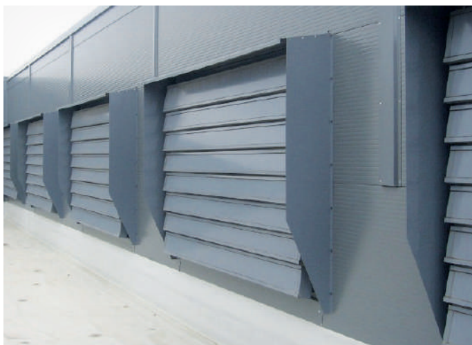
Foto. III-IV In der Fassade montierte mcr LAM Lüfter mit Regenabweiser
