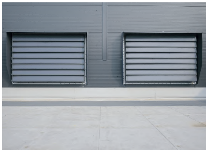
Zdjęcie. III–IV Klapy montowane fasadowo mcr LAM wyposażone w osłony przeciwdeszczowe
