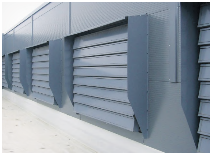
Zdjęcie. III–IV Klapy montowane fasadowo mcr LAM wyposażone w osłony przeciwdeszczowe
