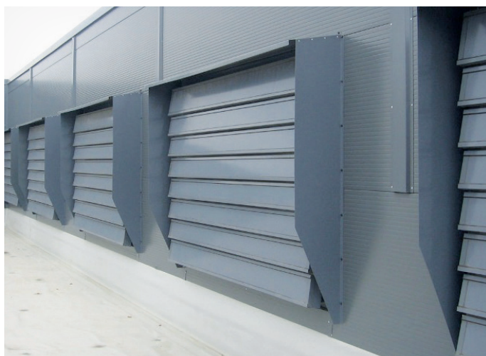
Zdjęcie. III-IV Kłapy montowane fasadowo mcr LAM wyposażone w osłony przeciwdeszczowe
