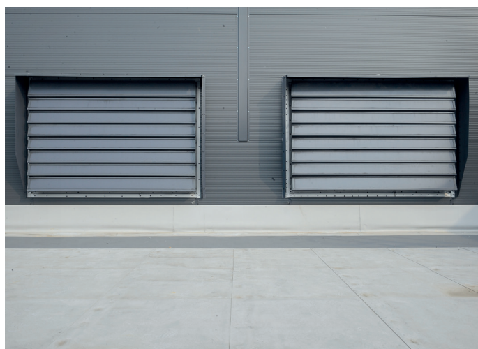
Zdjęcie. III-IV Kłapy montowane fasadowo mcr LAM wyposażone w osłony przeciwdeszczowe
