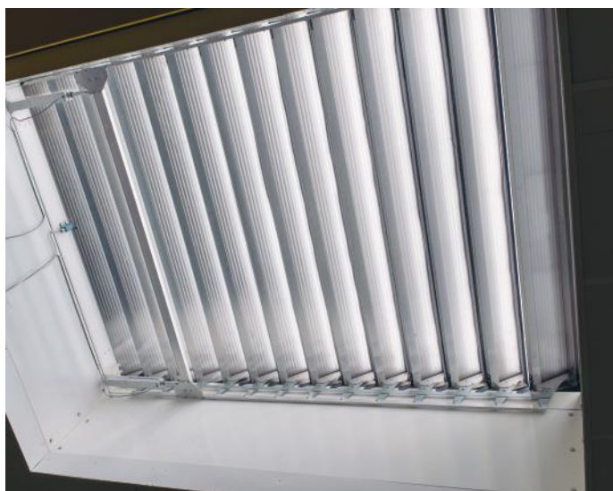
Abb. 39 – mcr LAM Lamellenlüfter – Dacheinbau, Innenansicht
