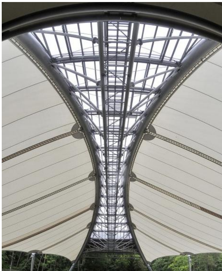
Rys. 49 – Zadaszenie obiektu kulturowego, poliwęglanowe
