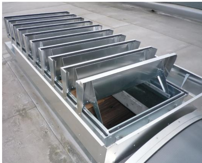
Rys. 43 – mcr LAM kłapa żaluzjowa – montaż na dachu
