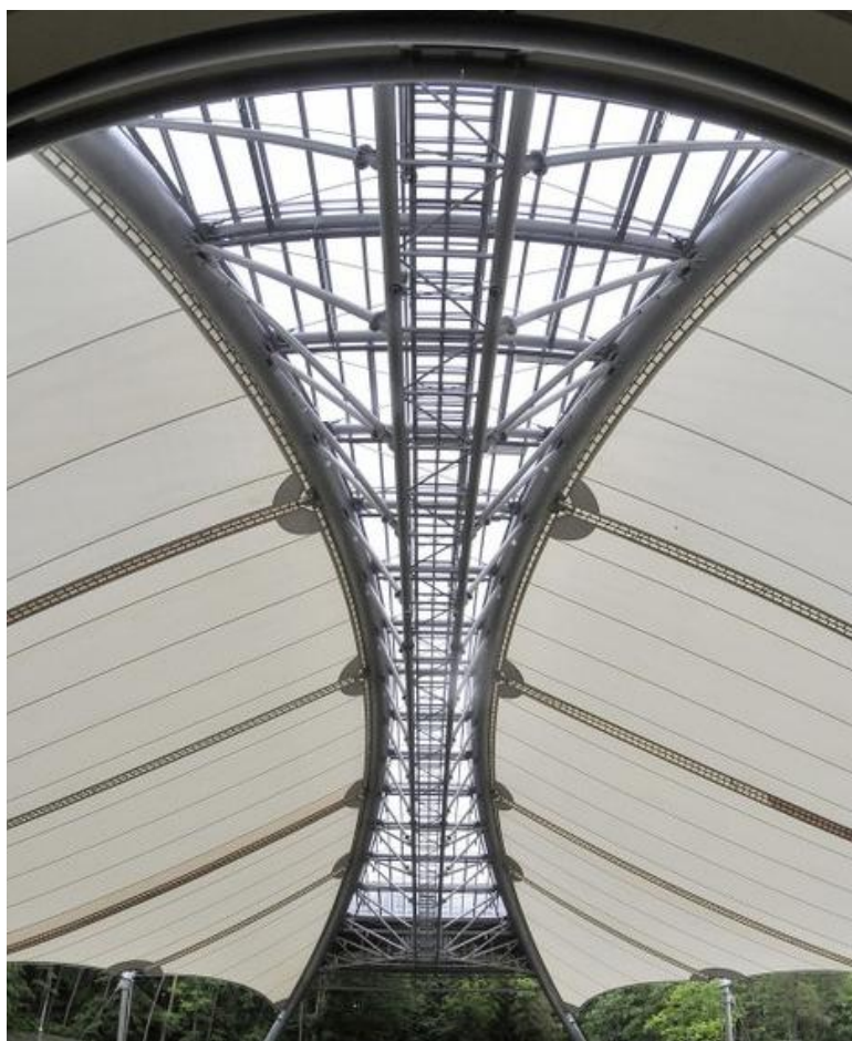
Rys. 49 – Zadaszenie obiektu kulturowego, poliwęglanowe
