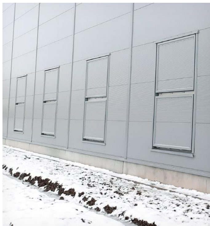
Rys. 55 – Klapy napowietrzające – widok od wewnątrz
