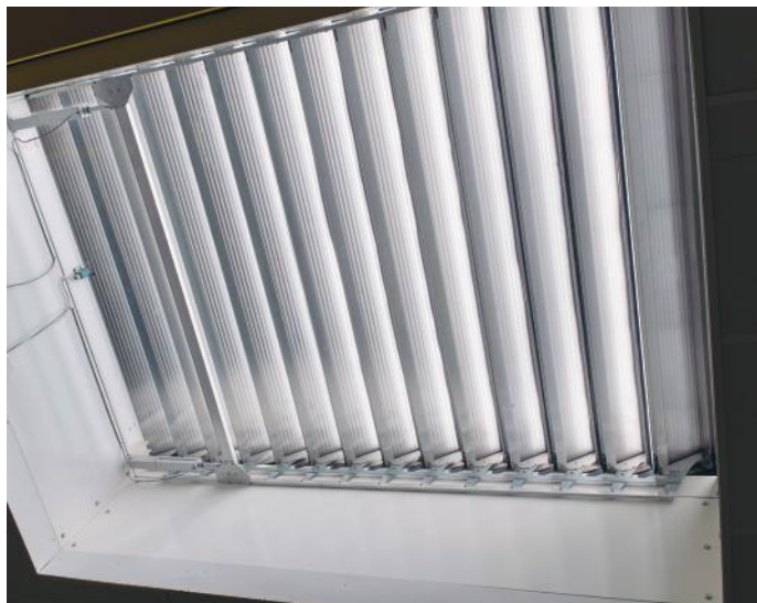
Rys. 42 – mcr LAM kłapa żaluzjowa – montaż na dachu, widok wewnętrzny
