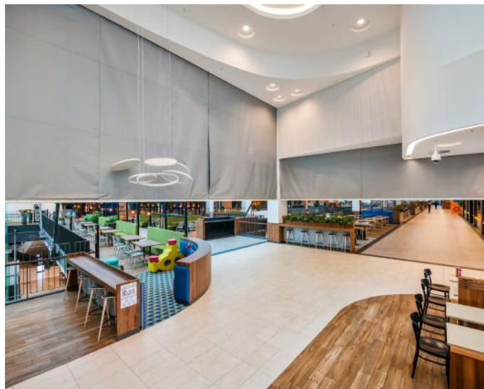
Rys. 47 – mcr PROSMOKE kurtyna dymowa materiałowa
