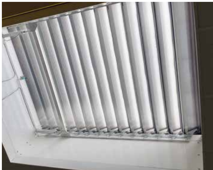
Rys. 42 – mcr LAM kłapa żaluzjowa – montaż na dachu, widok wewnętrzny
