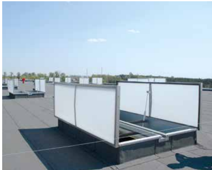
Rys. 8 – mcr PROLIGHT dwuskrzydłowe kłapy oddymiające
