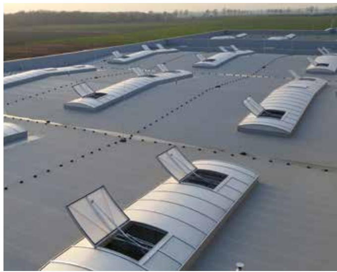
Rys. 4 – mcr PROLIGHT pasma świetlne z otwartymi klapami
