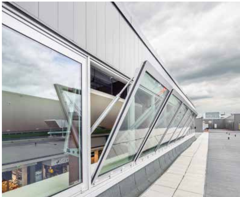
Rys. 36 – mcr OSO THERM okna oddymiające
