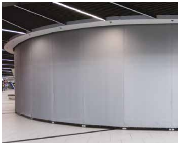
Rys. 47 – mcr PROSMOKE kurtyna dymowa materiałowa
