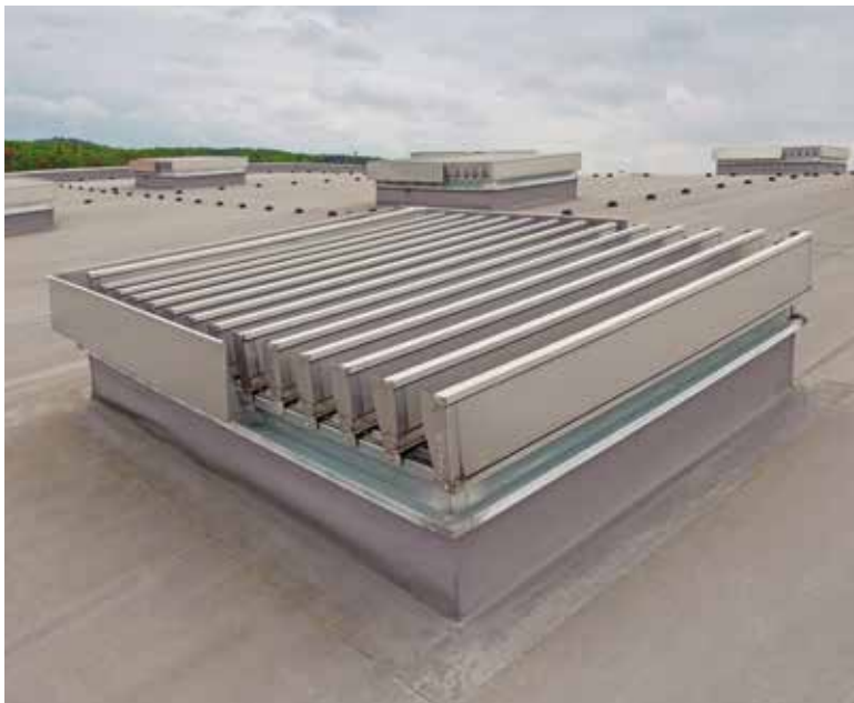
Rys. 40 – mcr LAM klapy żaluzyjne – montaż na dachu
