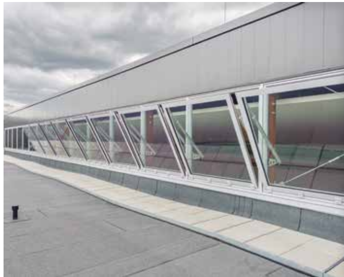
Rys. 39 – mcr OSO THERM okna oddymiające
