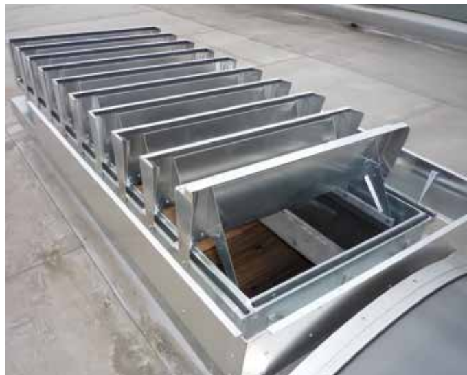
Rys. 43 – mcr LAM kłapa żaluzjowa – montaż na dachu
