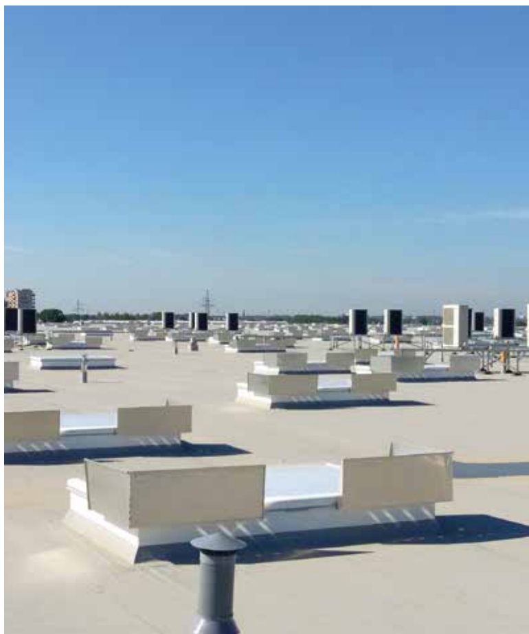
Rys. 18 – mcr ULTRA THERM klapy oddymiające
