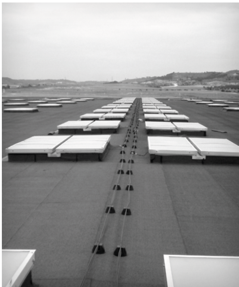
Rys. 6 – mcr PROLIGHT dwuskrzydłowe klapy oddymiające
