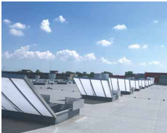
Rys. 7 – mcr PROLIGHT jednoskrzydłowe kłapy oddymiające
